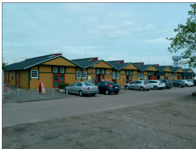
Eksisterende havnebygning med diverse faciliteter for lystbådehavns brugere set fra syd.
