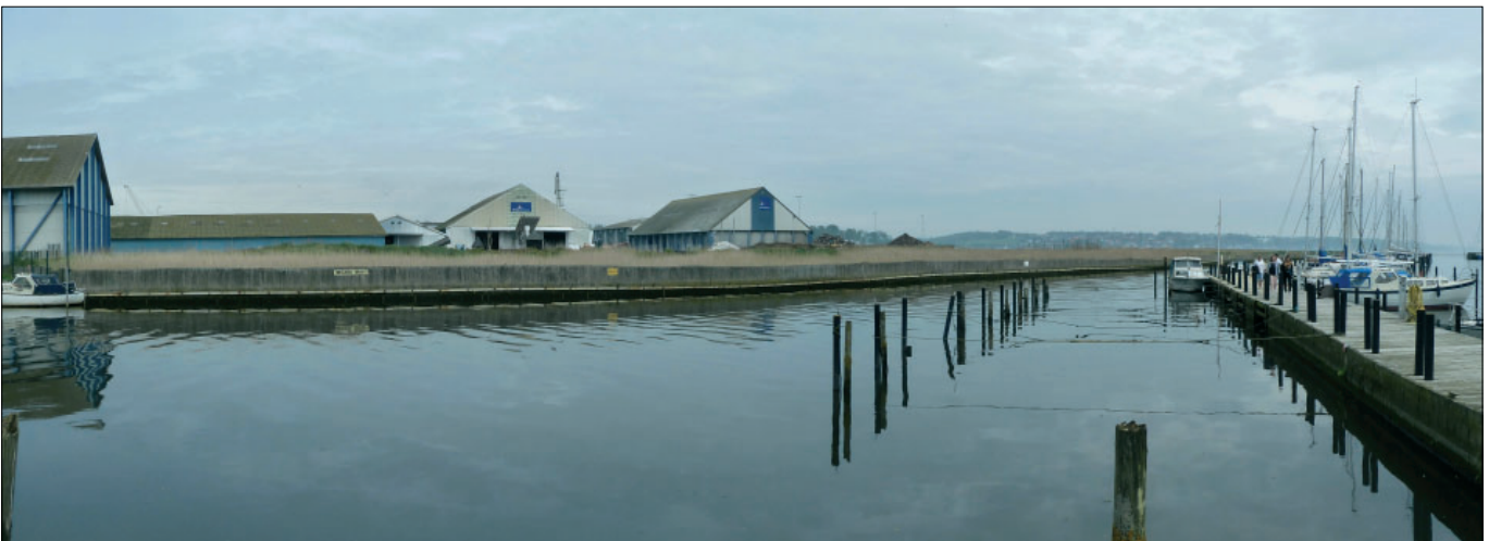
Ubebyggede arealer nord for Kolding Å, som er omfattet af lokalplanen. Til venstre og i baggrunden bebyggelser i Kolding Havn.
