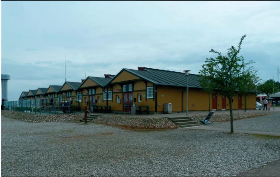
Den eksisterende havnebygning med bevaringsmæssig værdi set fra nord-vest.
